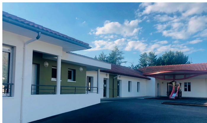
De nombreux travaux réalisés à l'école
